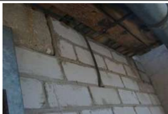
Būve ar kadastra apzīmējumu 1700 023 0078 009, garāža E-8, elektroapgāde
